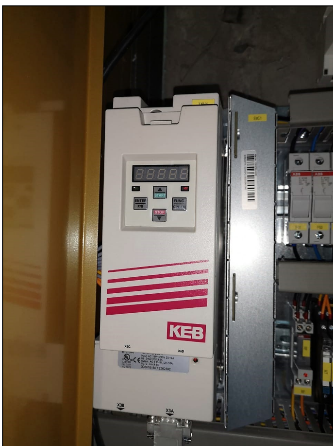
Частотный преобразователь домашнего лифта
