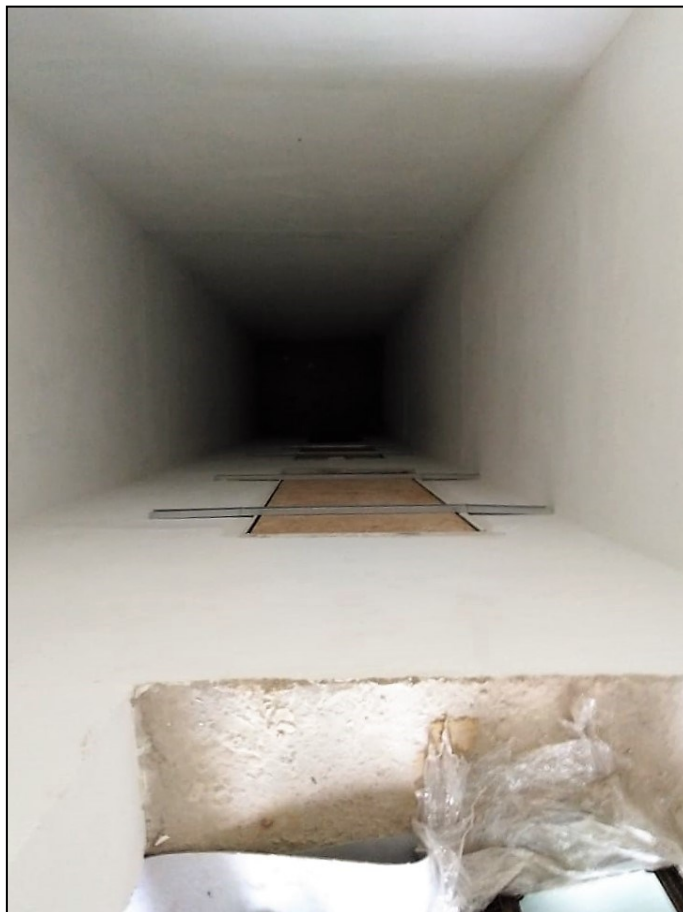
Изолированная шахта лифта 2000(ш) x 1600 (г)
