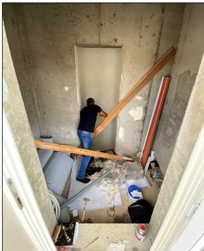
Начало монтажных работ
