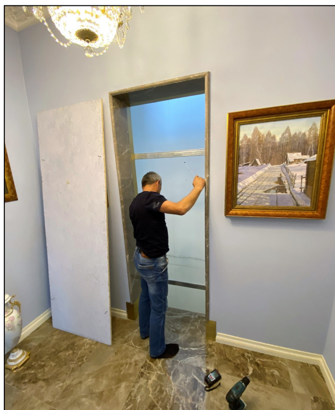
Установка изоляции между шахтой и холлом
