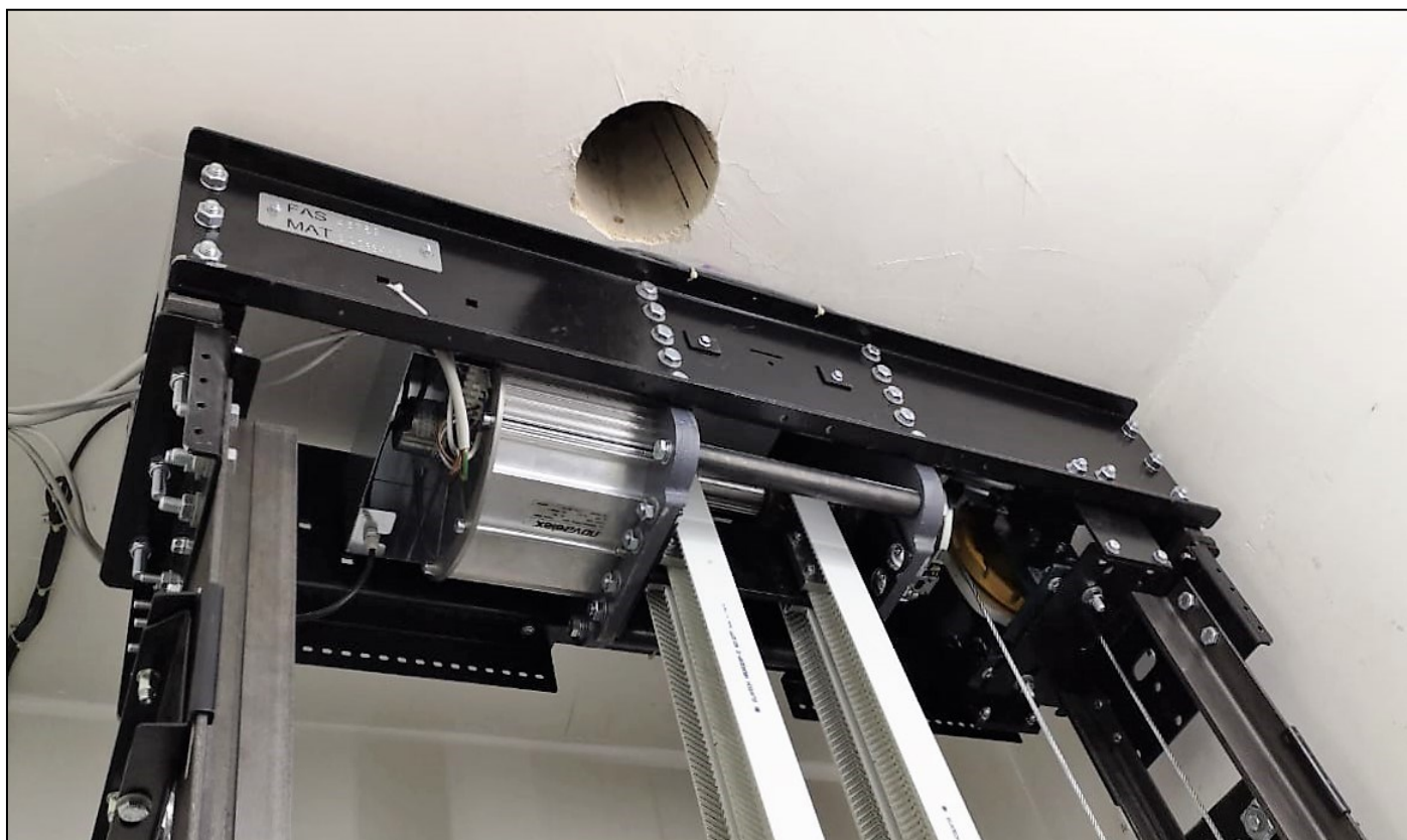
Безредукторная лебедка домашнего лифта «GENIUS» производства «NOVA ELEX»
