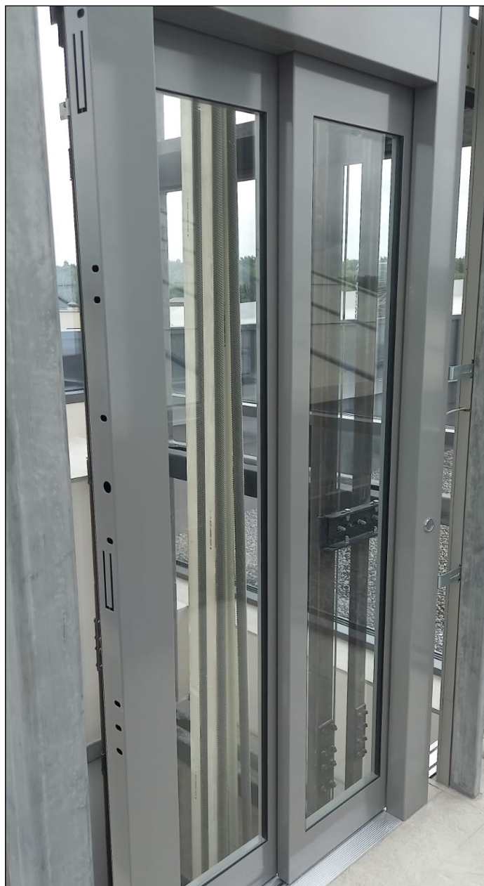
Вид на смонтированный лифт с крыши коттеджа
