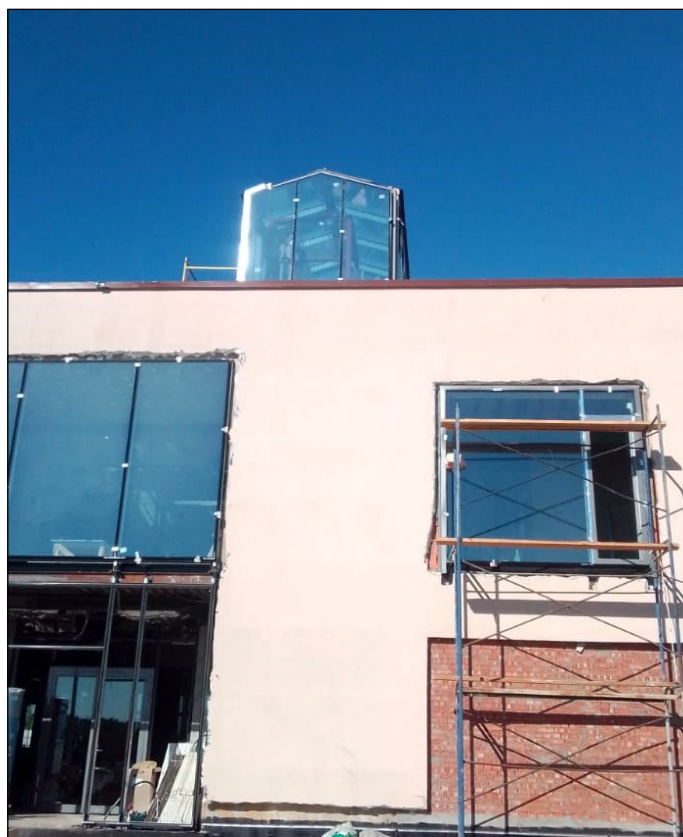
Стальной каркас в стеклянной зашивке
