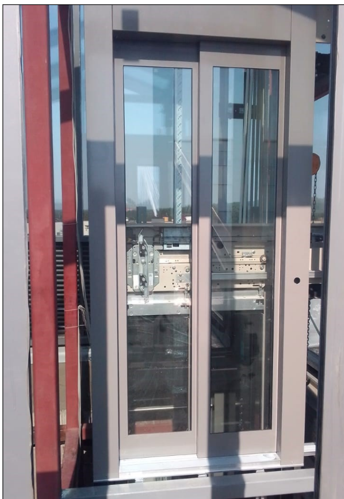
Электрический лифт на завершающем этапе монтажа
