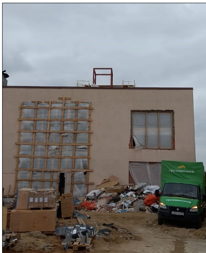
Монтаж стального каркаса для лифта на крыше дома
