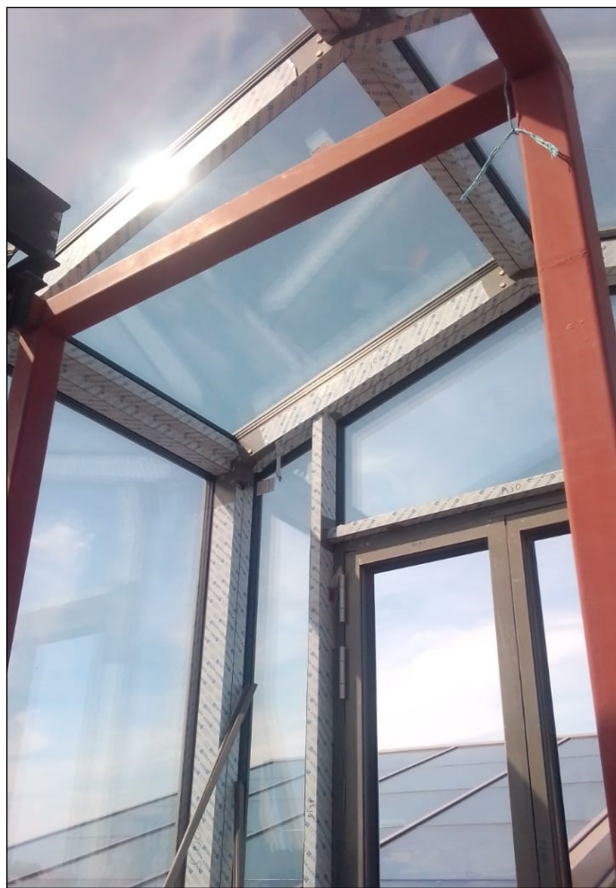
Неокрашенный стальной каркас на крыше коттеджа
