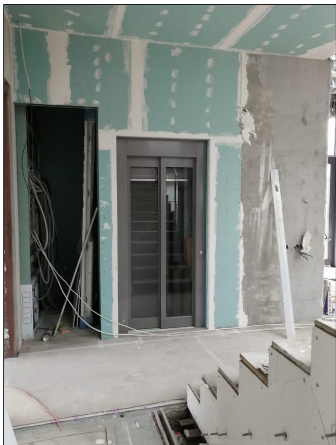
Этажная площадка и стеклянные двери лифта
