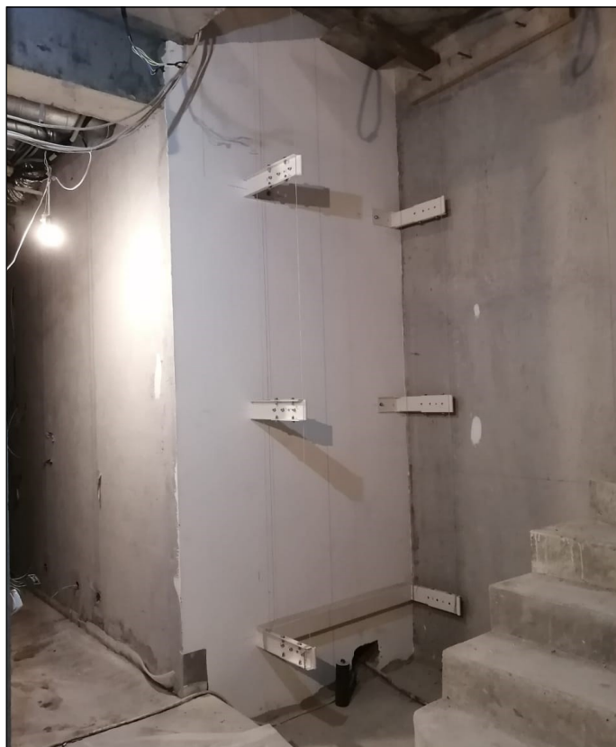
Установка кронштейнов направляющих лифта
