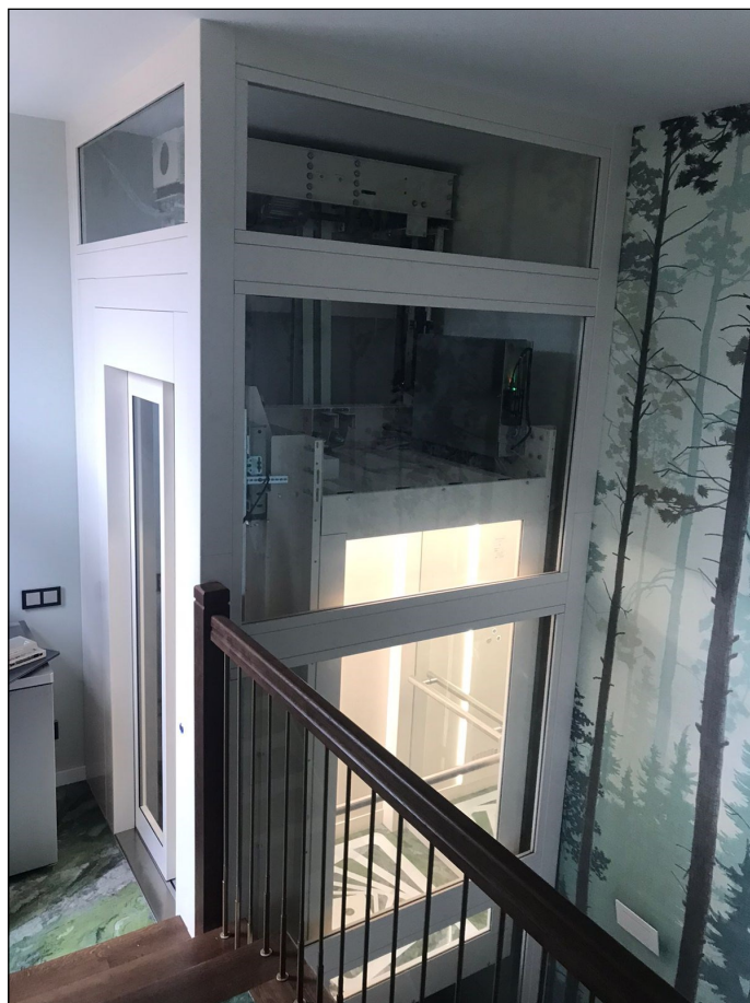
Остекленная кабина и шахта домашнего лифта
