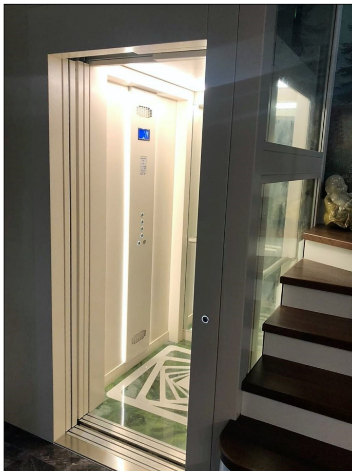
Стеновая панель кабины лифта из крашеной стали
