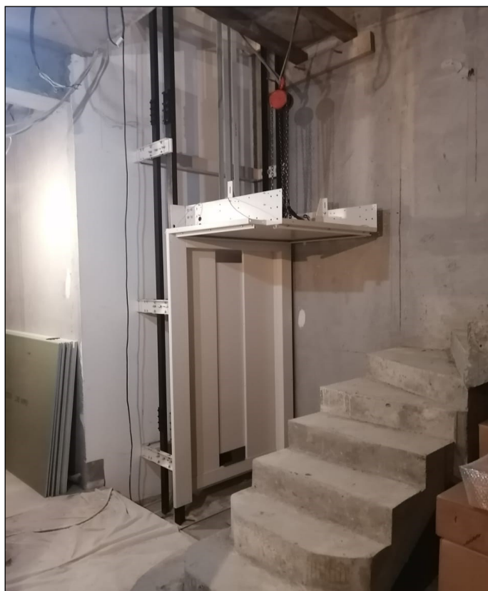
Сборка кабины пассажирского лифта NOVA ELEX
