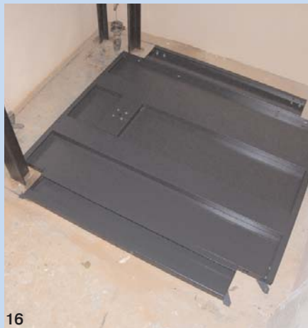
16. На металлическое основание пола кабины лифта укладывают лист керамогранита
