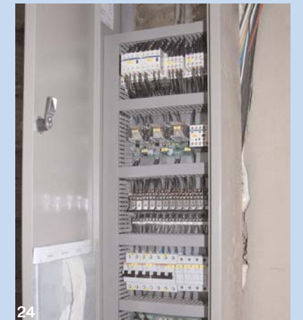
24. Когда станция управления установлена, можно приступить к пусконаладочным работам
