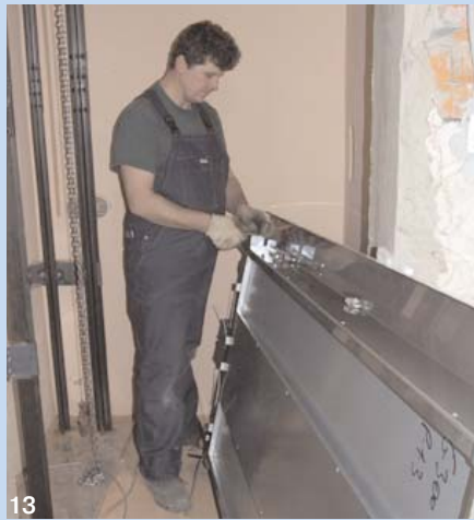
13. Подготовка задней стенки кабины лифта к монтажу на первой секции нижних направляющих
