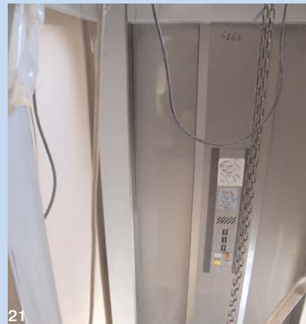
21. Конструкция кабины позволяет при необходимости сделать выход в три стороны (на каждом этаже — в свою)
