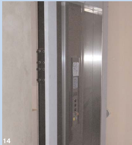
14. На задней стенке кабины находится приказной аппарат с нумерацией этажей и кнопкой экстренной остановки
