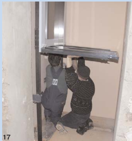
17. Монтажники установили основание кабины, закрепив его на болтах на задней стенке лифта
