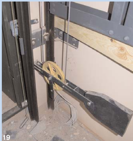
19. Шкивы ограничителя и натяжителя обязательно должны находиться в одной плоскости
