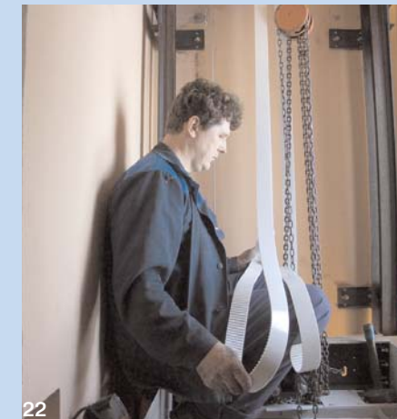
22. Для лифта используется два ремня подвески. Закрепление концов ремней производится под рамой привода
