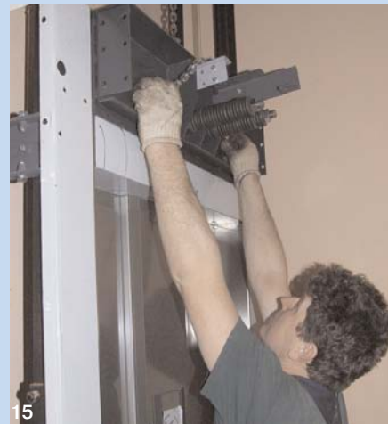
15. После завершения монтажа задней стенки кабины рабочие приступили к установке верхней балки
